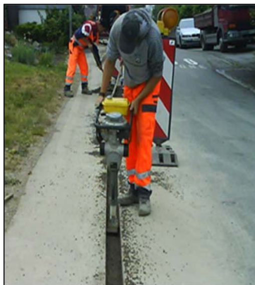
Abbildung 2: Einsatz eines Vibrationsstampfers zur Verdichtung des Einkornbetons
