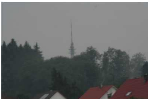
Sicht vom Wasserbehälter
