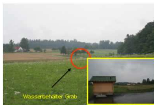
Möglicher Antennenstandort am Wasserbehälter
